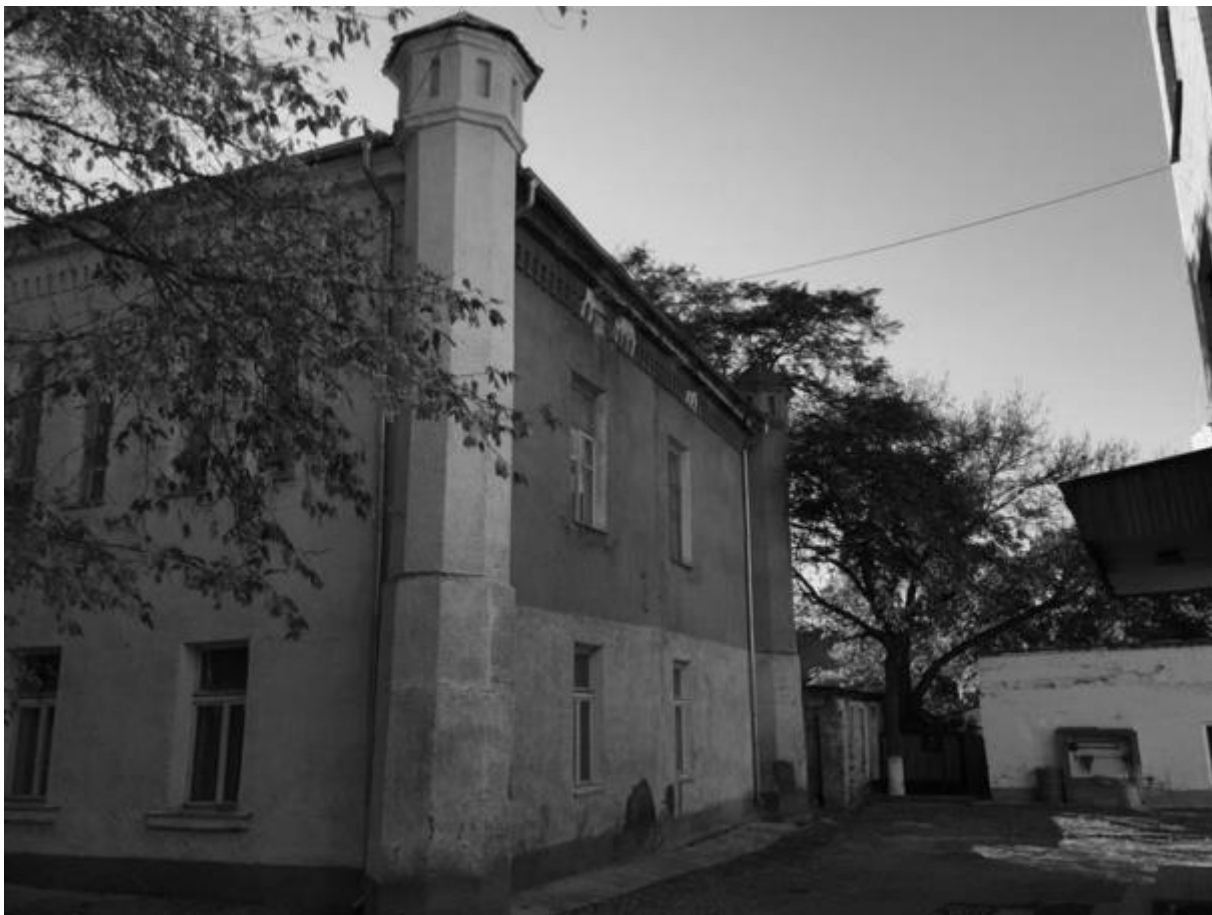
Фото 4. Объект культурного наследия регионального значения «Здание бывших казарм Ахульгинского батальона», 1905 г., Ставропольский край, г. Пятигорск, пр. Калинина, 93. Западный фасад.
