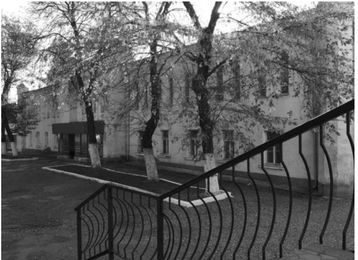
Фото 2-3. Объект культурного наследия регионального значения «Здание бывших казарм Ахульгинского батальона», 1905 г., Ставропольский край, г. Пятигорск, пр. Калинина, 93. Общий вид памятника с дворовой территории.
